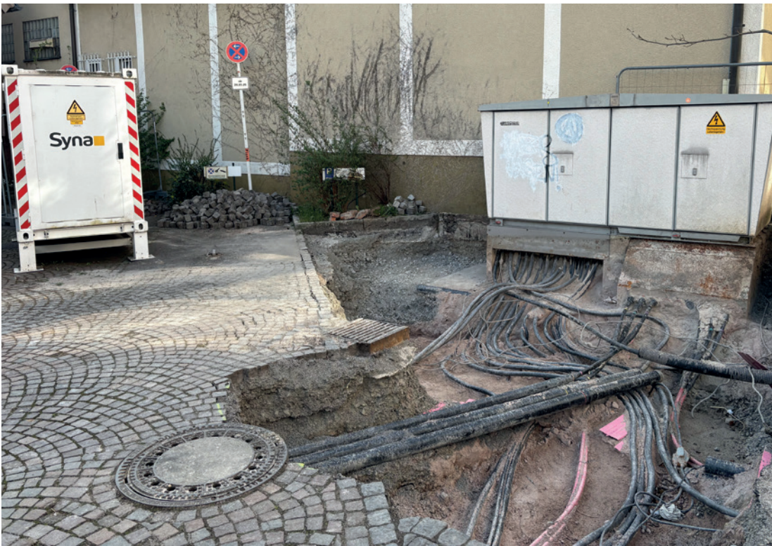
Austausch einer alten Trafostation gegen eine digitale Ortsnetzstation im KAWAG-Netzgebiet.
